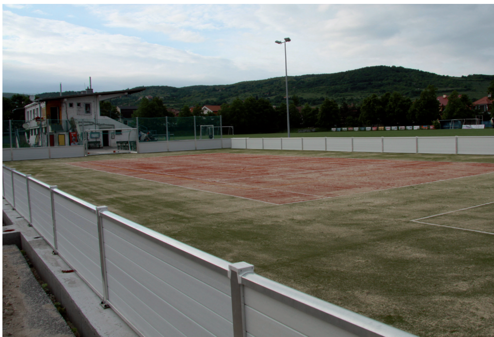
V areáli futbalového štadióna vyrástlo nové multifunkčné ihrisko. Na jeho výstavbe sa podieľali aj pracovníci Sociálneho podniku.
